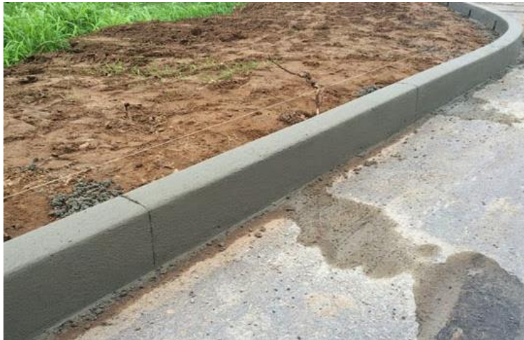
Meio-fio moldado in loco
